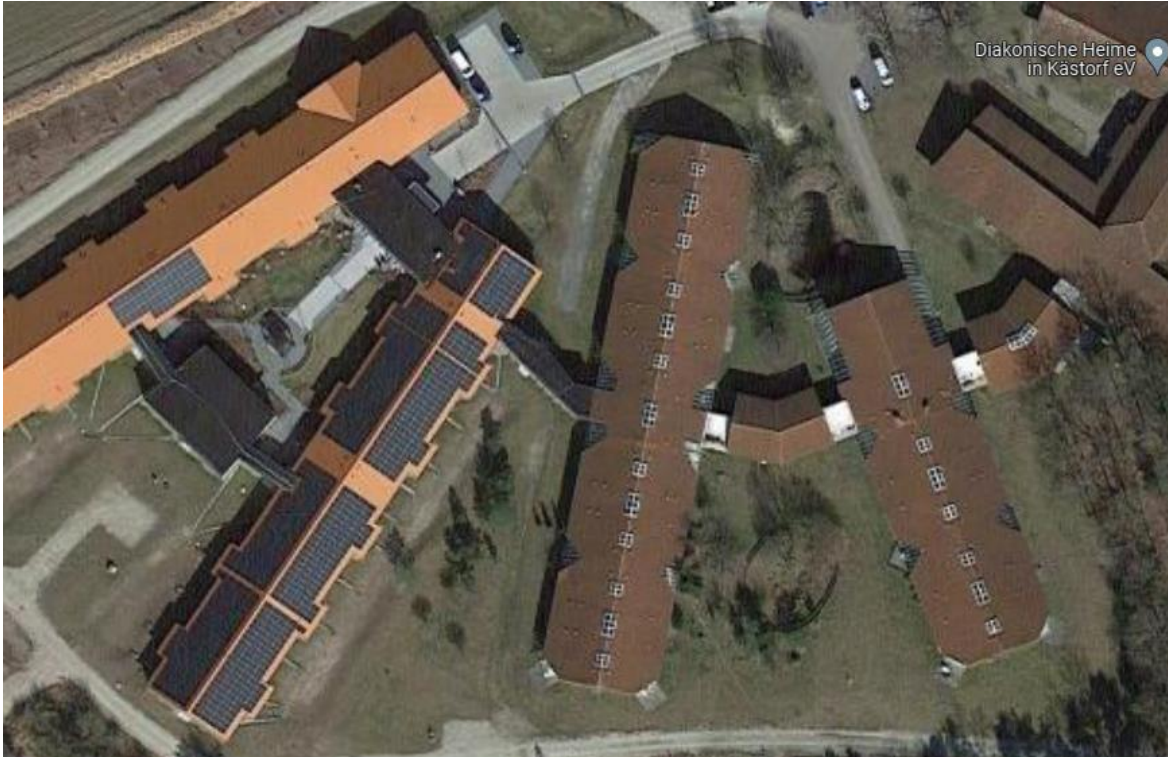
PV-Anlage Brömmelkamp 236 kWp „Versorgung einer Pflegeeinrichtung“
